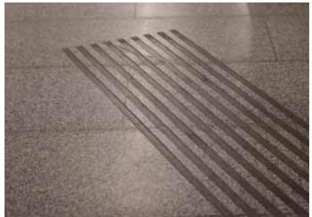
Das taktile Leitsystem erhöht die Mobilität sehbehinderter und blinder Menschen und trägt auch wesentlich zu deren Sicherheit bei. Im Bild: Rillenstein für Granitsteinböden
