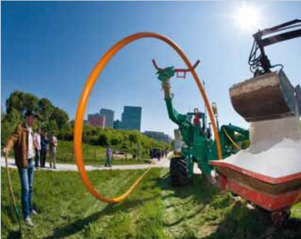
Ausbau der Versorgungsnetze: Gasrohrverlegung mittels Pflug
