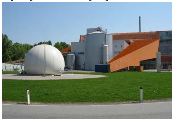
Biogasanlage und Müllverbrennungsanlage Pfaffenau
