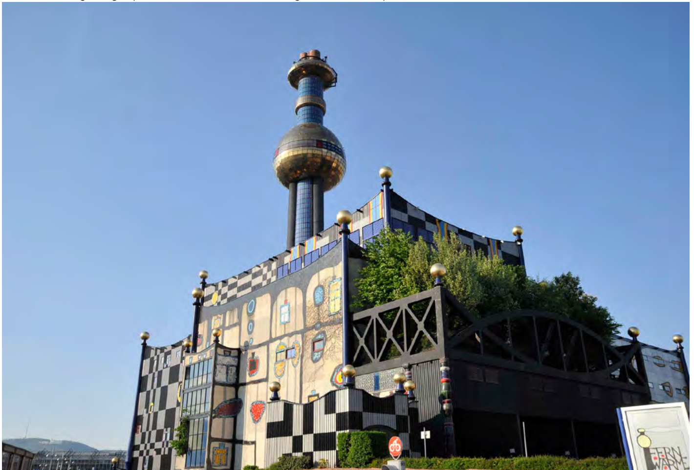
Müllverbrennungsanlage Spittelau (wird bis Mitte 2015 energiewirtschaftlich optimiert)
