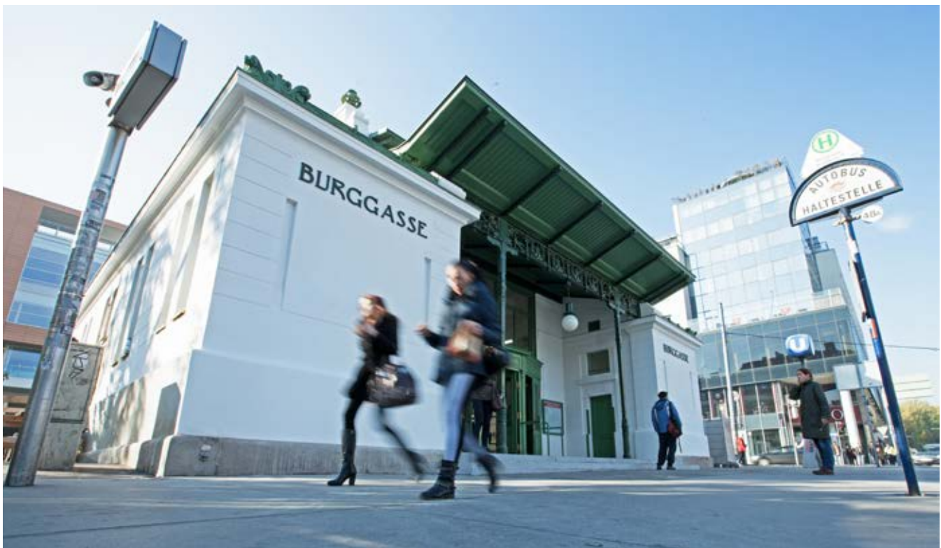
U6 Station Burggasse
