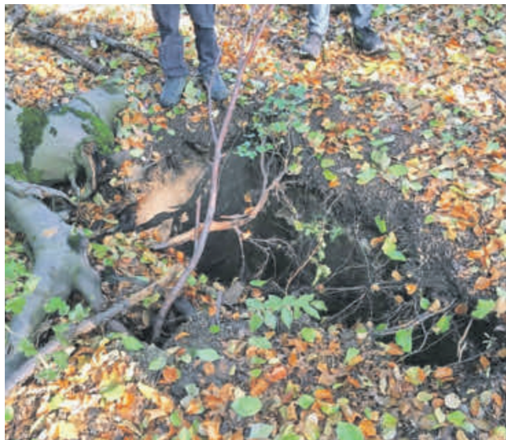
Unmittelbar bei der Jubiläumswarte wurde die eingefallene Zisterne entdeckt. Die Wiener Forstbetriebe (MA 49) ließen sie zuschütten und planieren.
