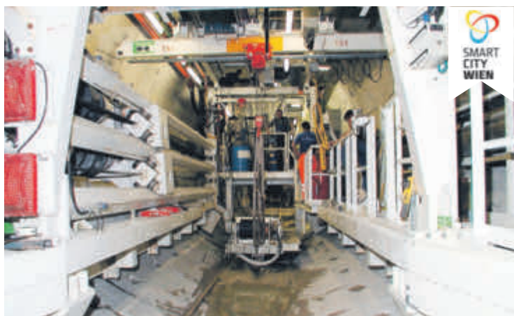
Blick ins Innere des Tunnelbohrers
