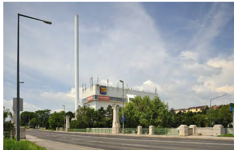
Die Müllverbrennungsanlage am Flötzersteig © Schaub Walzer (PID)
