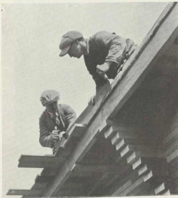
Abb. 33. Selbsthilfesiedlungsbau Kleinmünchen-Linz: Besäumen der rauhen Dachschalung entlang des Flugsparrens
