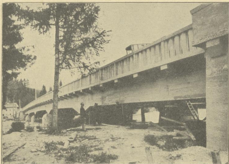
Bundesstraßenbrücke bei Reutte in Tirol.
