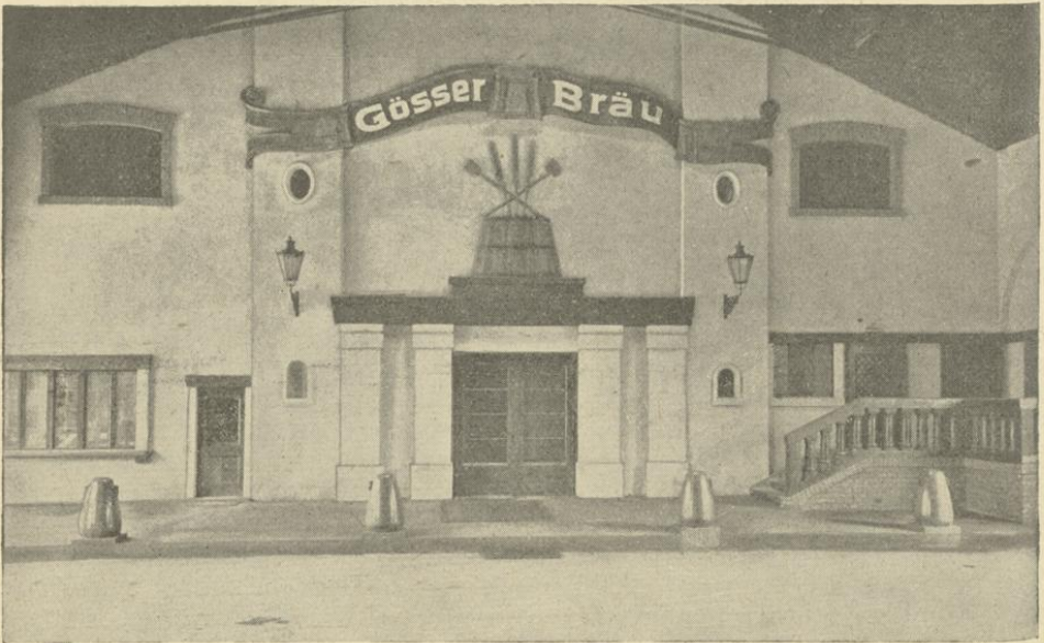
Depôt samt Kühlanlage der Gösser Brauerei in Wien.
