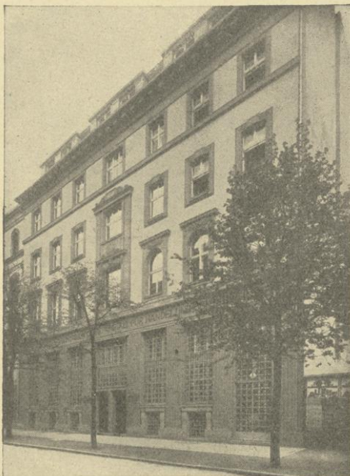
Bankgebäude der Oesterr. Creditanstalt für Handel und Gewerbe in Graz.
