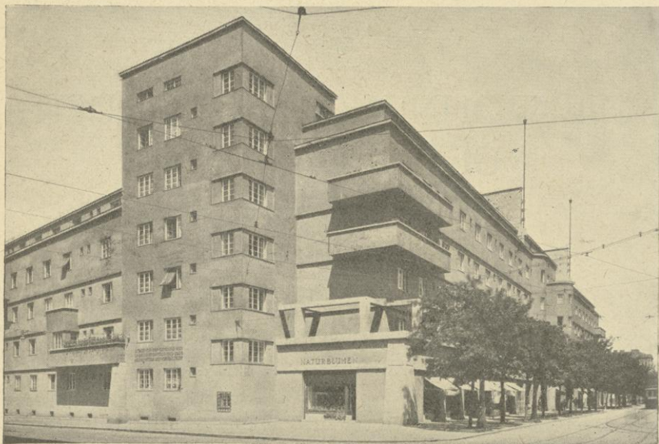
Volkswohnhaus, XII., Steinbauergasse—Klährgasse. „Bebelhof“. Entwurf: Wiener Stadtbauamt, Architekt Oberbaurat Karl Ehn.
