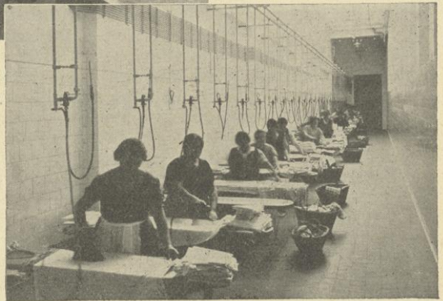
Zentral-Waschküche in einer Wohnhausanlage der Gemeinde Wien.
