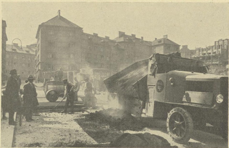
Herstellung von Walzasphalt.
