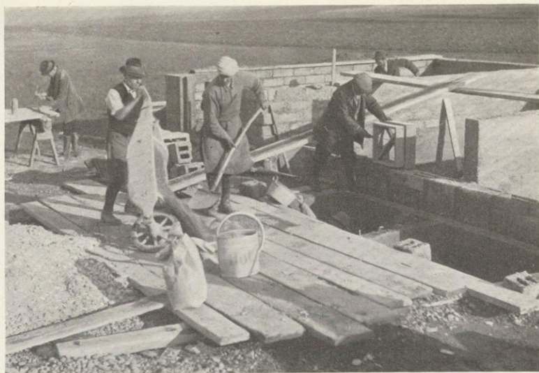
Abb. 19. Siedlungshaus St. Peter-Linz Type A : Ausführung des Keller- und Sockelmauerwerkes
