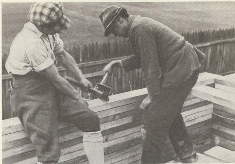
Abb. 32. Selbsthilfesiedlungsbau Kleinmünchen-Linz: Nagelung der Pfostenlage der Bohlenwände „auf Katzensprung“
