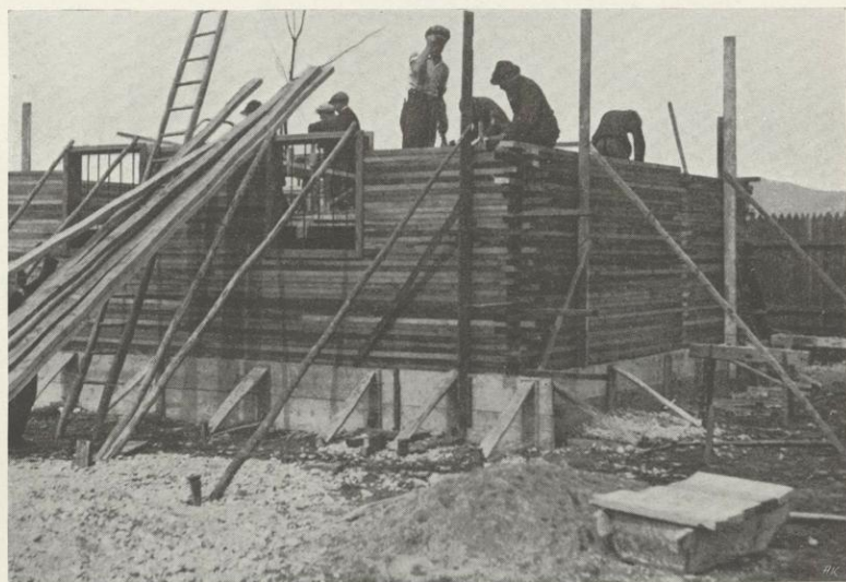
Abb. 20. Siedlungshaus St. Peter-Linz Type A : Aus aufeinanderge-nagelten Pfosten hergestellte Bohlenwände
