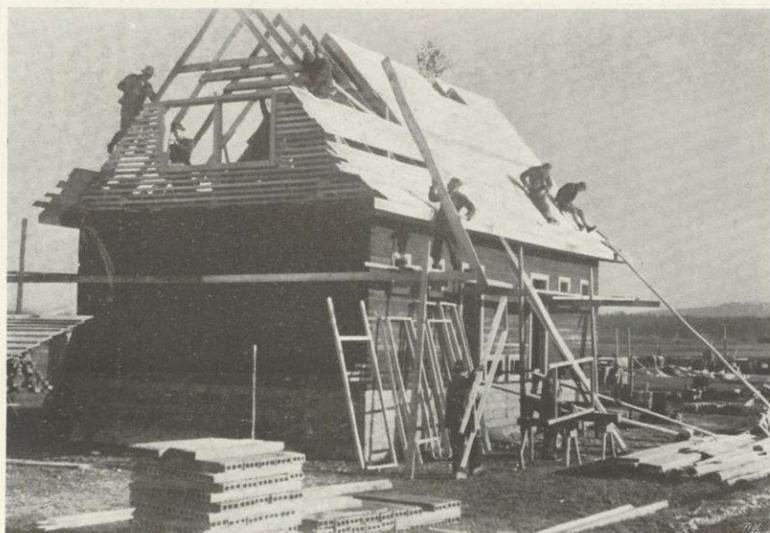
Abb. 22. Siedlungshaus St. Peter-Linz, Type A: Haus vor Fertigstellung; Anbringen der Dachschalung für die Eternitdeckung
