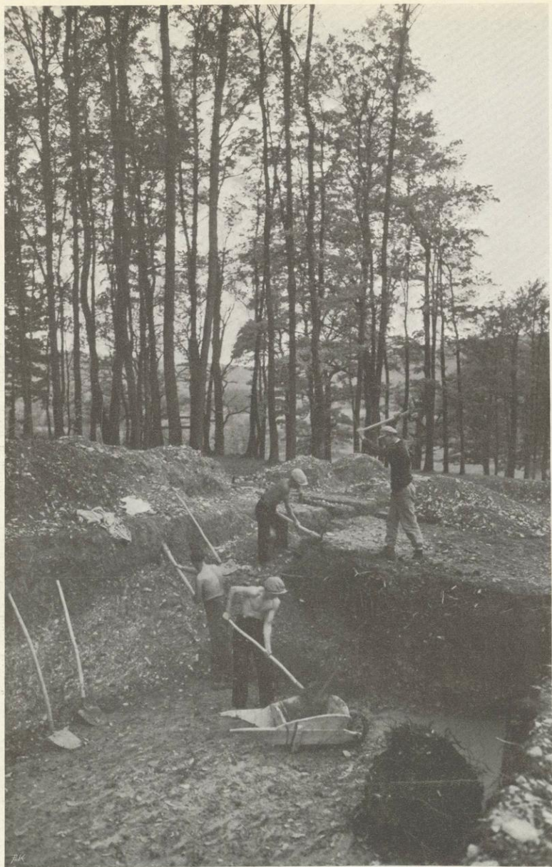
Abb. 36. Freiwilliger Arbeitsdienst: Geländeaufschließung für den Siedlungsaufbau (1. freiwilliges Arbeitslager Leithenwald)
