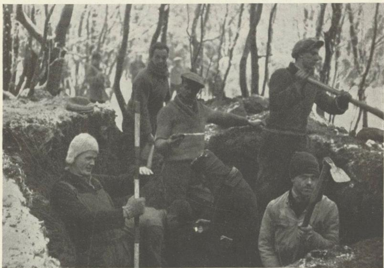
Abb. 44. Freiwilliger Arbeitsdienst: Führerschulungslager in Bernstein, Burgenland; Erdarbeiten (Träger des Dienstes: Ver. „Studentischer Arbeitsdienst“ und „Österr. Arbeitsdienst“)
