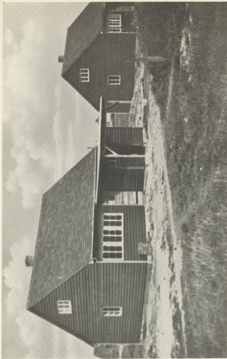
Abb. 7. Reichskleiniedlung Karlsruhe; Übernahme ortsüblicher Baumaterialien und Bauweisen. (100 Siedlerstellen; Riegelfachwerkbauten mit Lehmauswicklung, außen Stülpschalung, innen gehobelte Holzverschalung mit Leistendeckung, gute Grundrißausbildung.)
