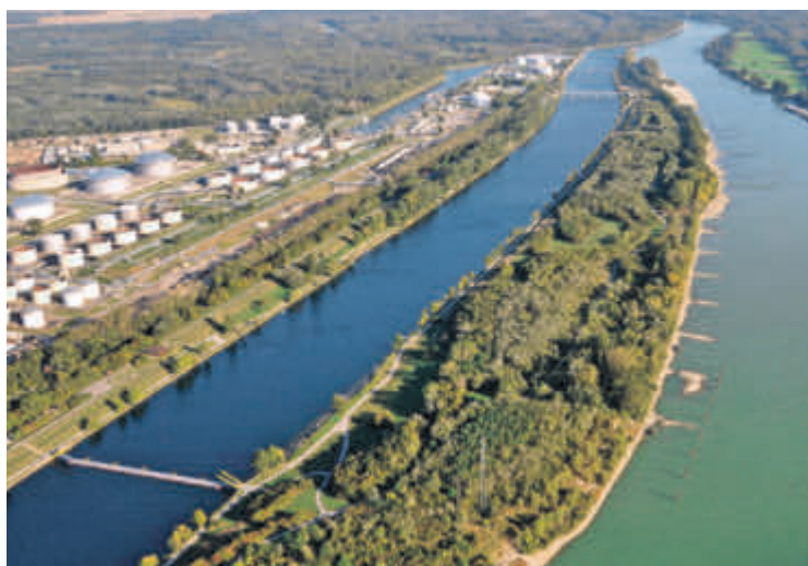
Luftaufnahme vom südlichen Teil der Donauinsel: Dank ihrer und des Entlastungsgerinnes hat Wien das Jahrhunderthochwasser 2013 gut überstanden.
