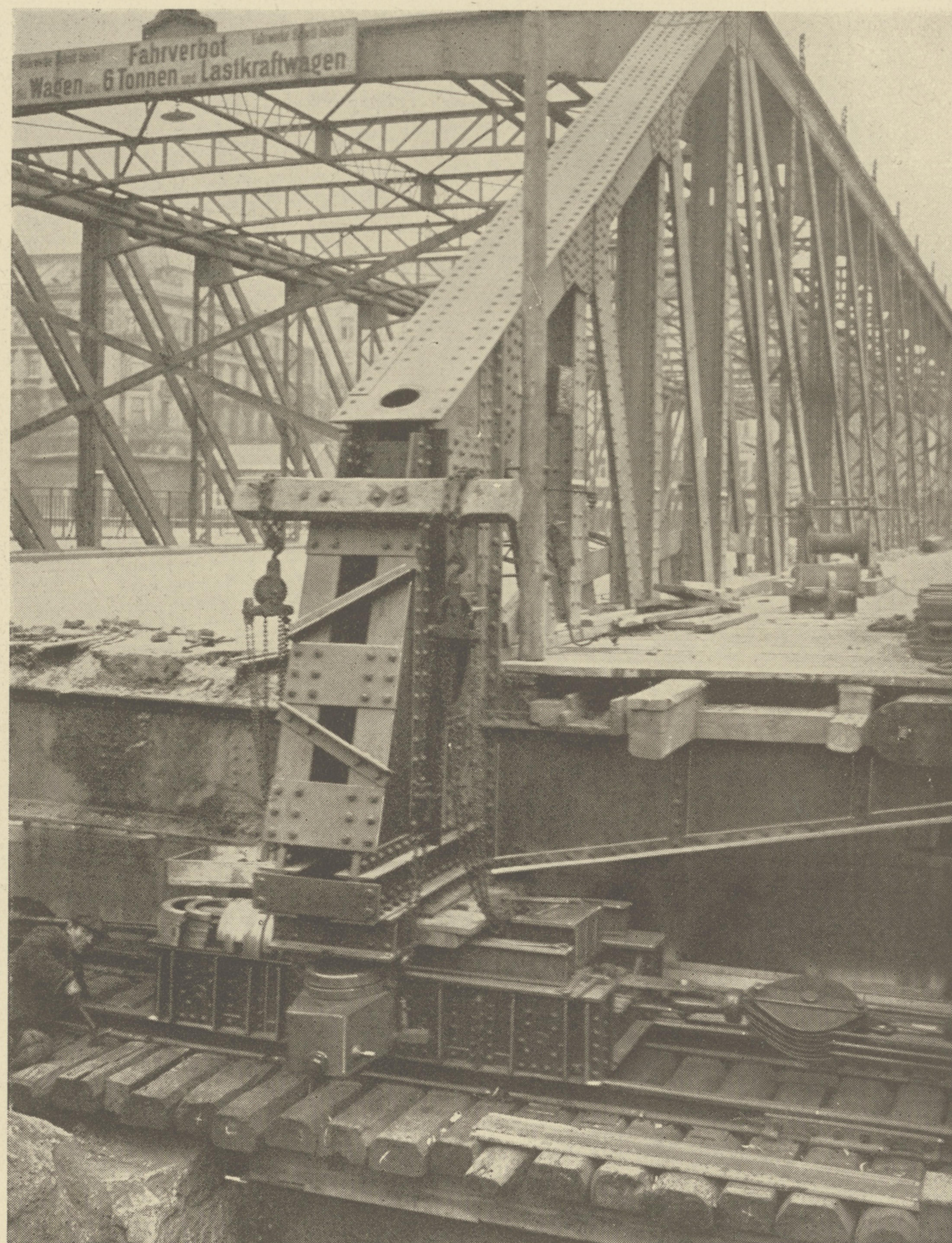
Verschiebung der alten Brücke; Auflagerung des Trägerwerkes auf einen Verschubwagen; Glyzerinölpumpe unter den Hubkonsolen zum Anheben.
