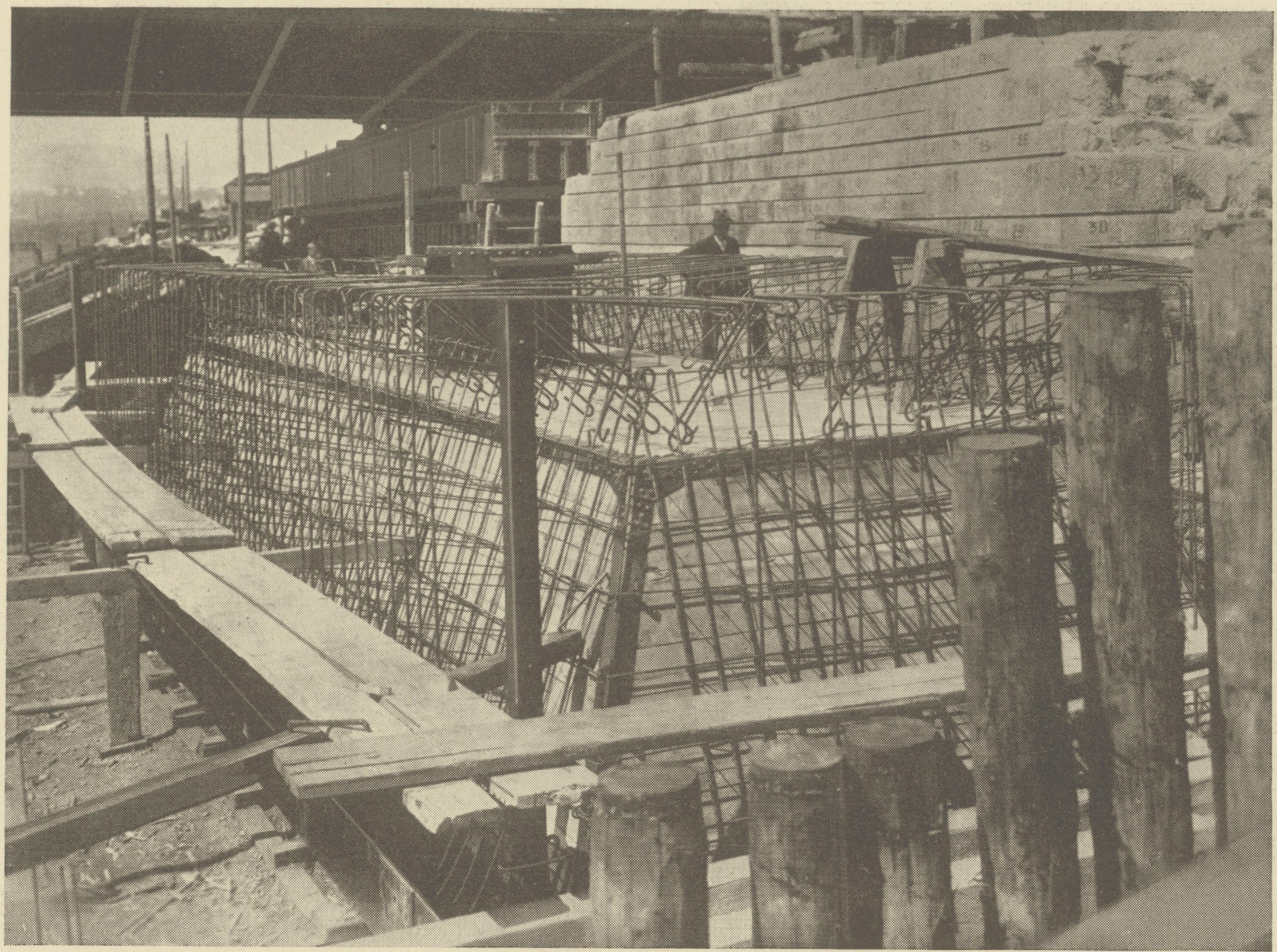
Gründung des linksseitigen Uferpfeilers. Eisenarmierung eines Kaissons in Montierung. Im Hintergrund das alte Widerlager.
