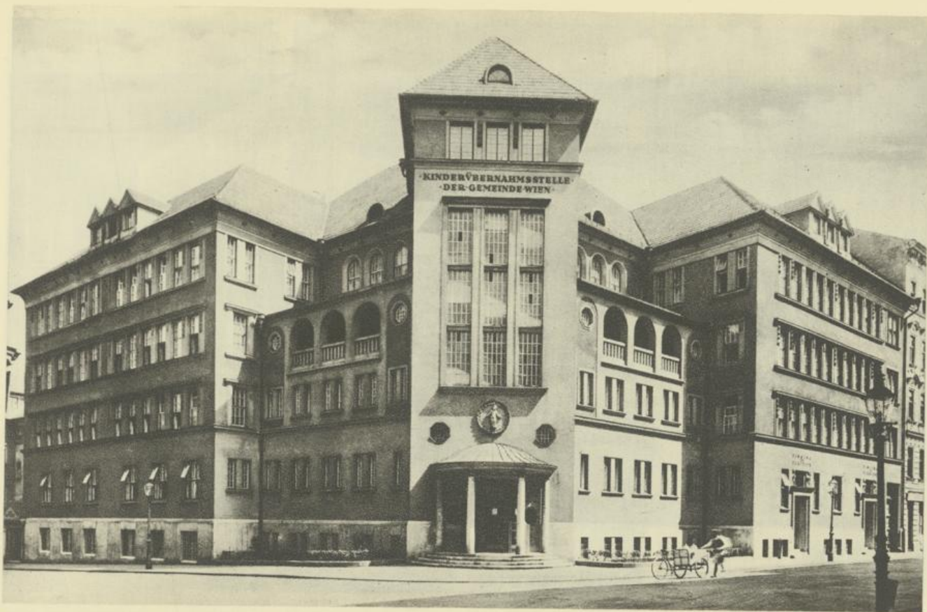
Kinderübernahmsstelle, IX., Ayrenhoffgasse Entwurf: Oberstadtbaurat A. Stöckl Straßenbahn: Ring—Schottentor/37, 38, 39
