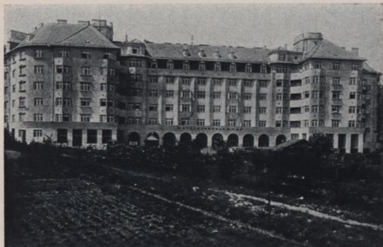
1922—1923 „METZLEINSTALERHOF“, WOHNHAUSBAU DER GEMEINDE WIEN
