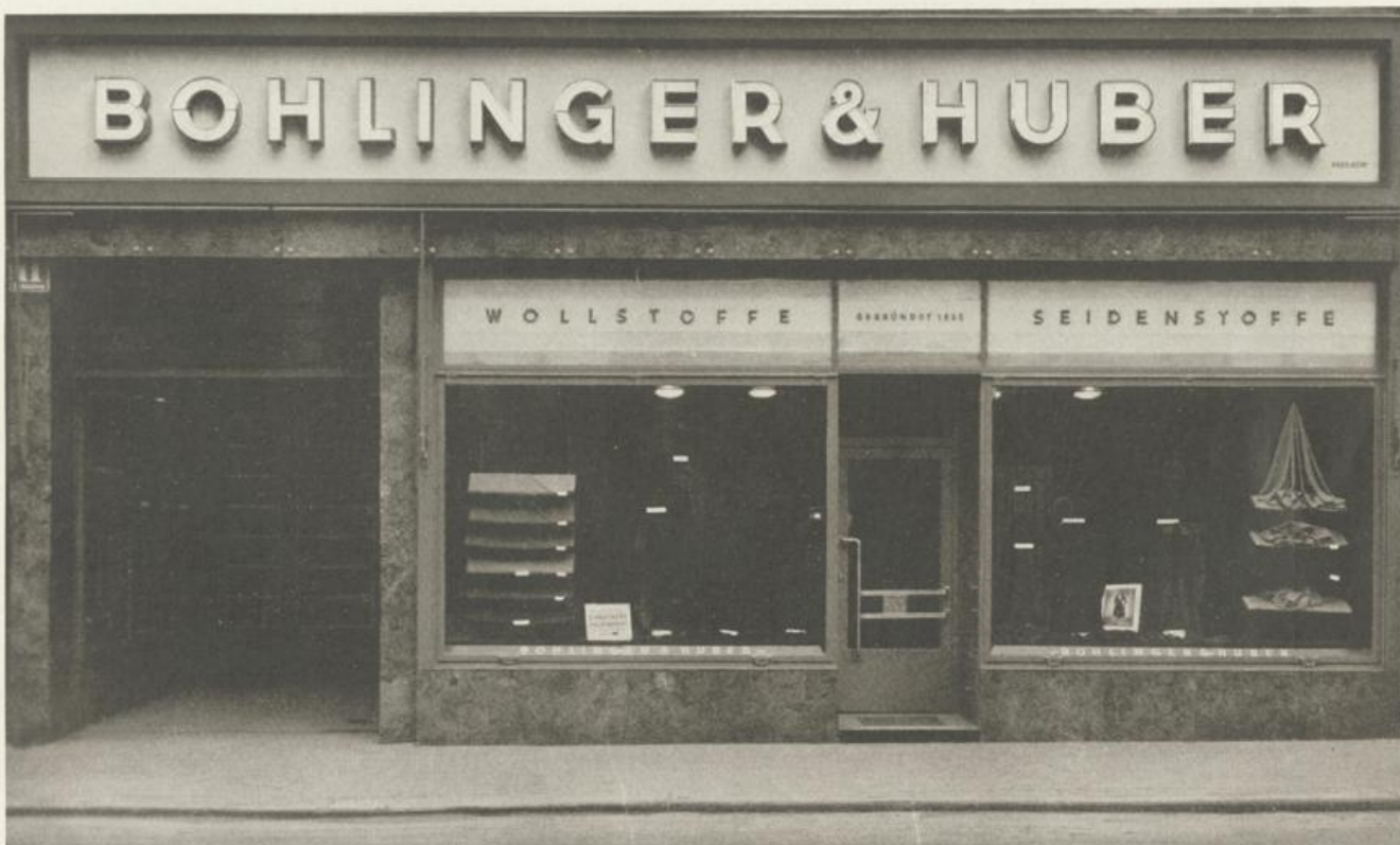
LADENUMBAU BOHLINGER-HUBER, WIEN, I., TUCHLAUBEN 11
