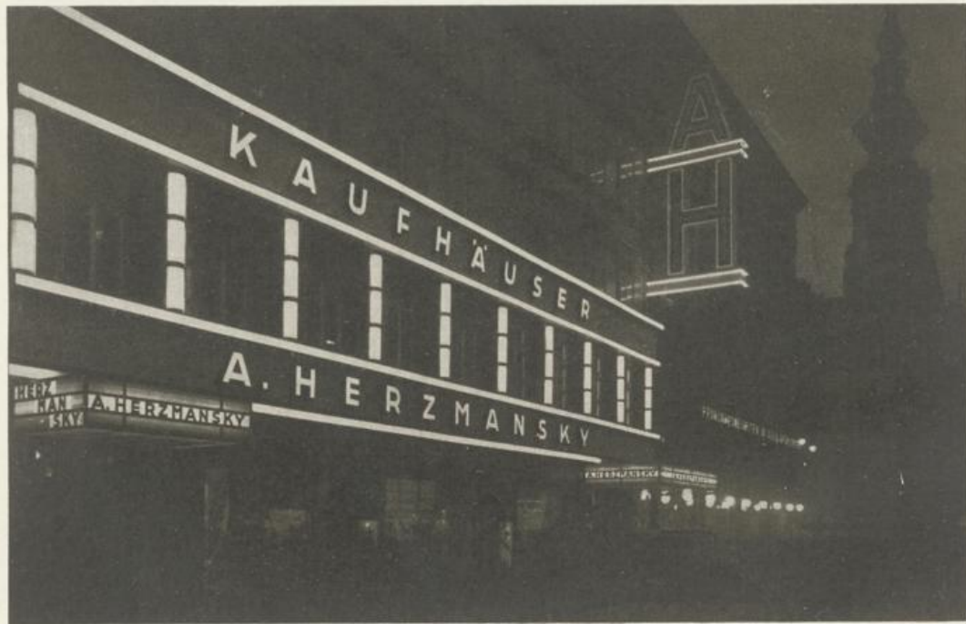
FASSADENUMBAU, KAUFHÄUSER A. HERZMANSKY-WIEN
