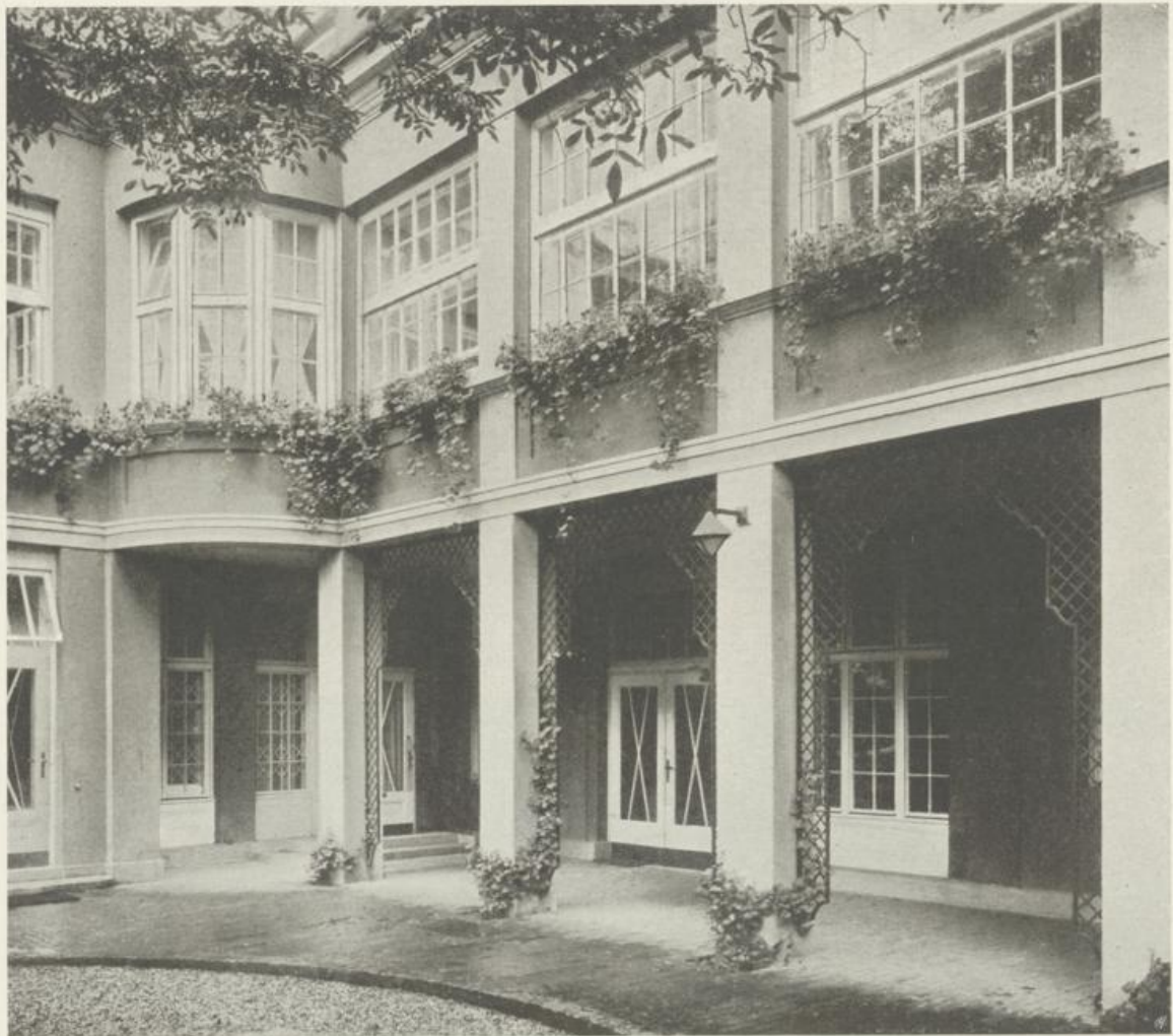
Zubau der Veranda mit Erker
