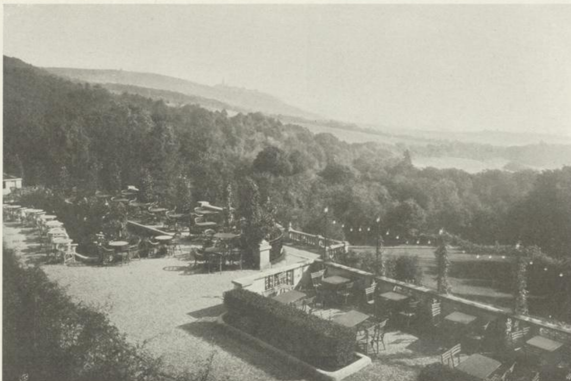
Draufsicht auf einen Teil der Terrasse
