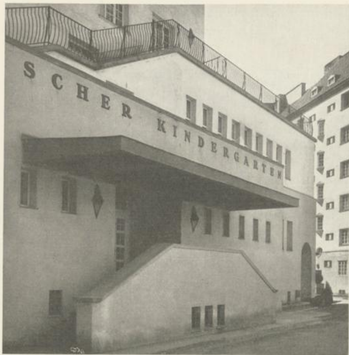
„AM FUCHSENFELD“ Volkswohnhausanlage der Gemeinde Wien im XII. Bezirk.
