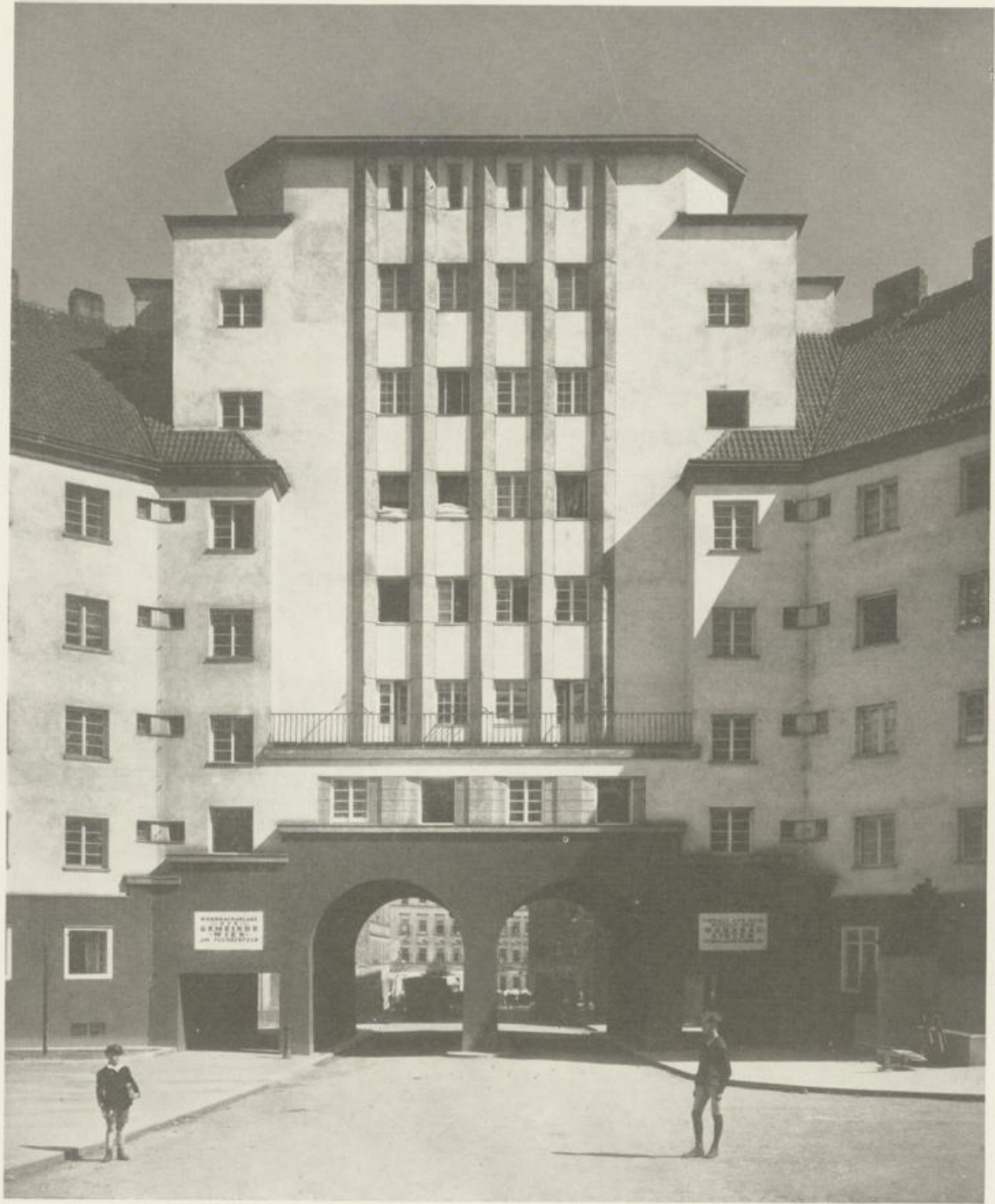
Straßenüberbauung vom Platz aus gesehen
