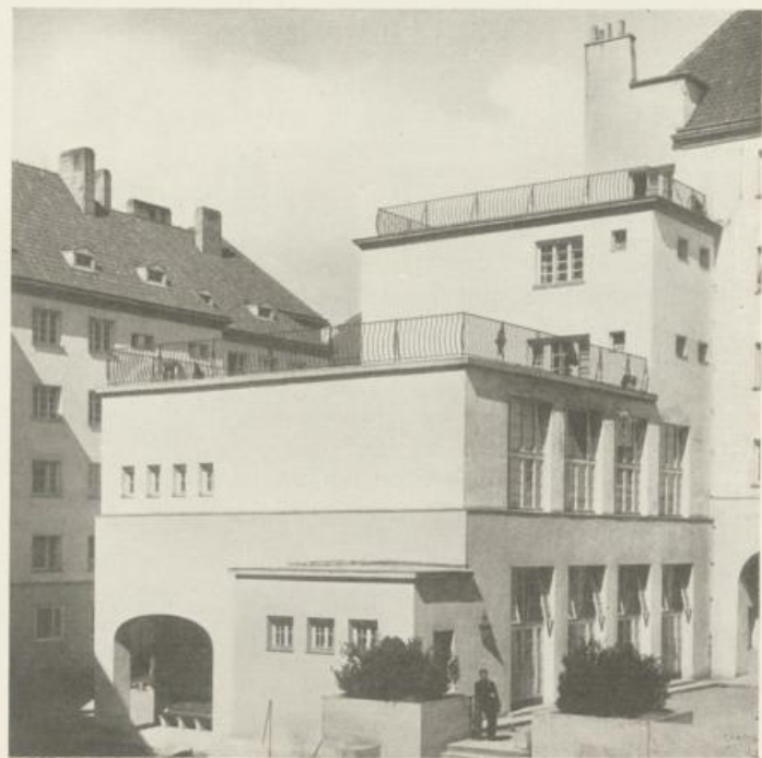
2 Ansichten von dem in einen der Gartenhöfe eingebauten Kindergarten
