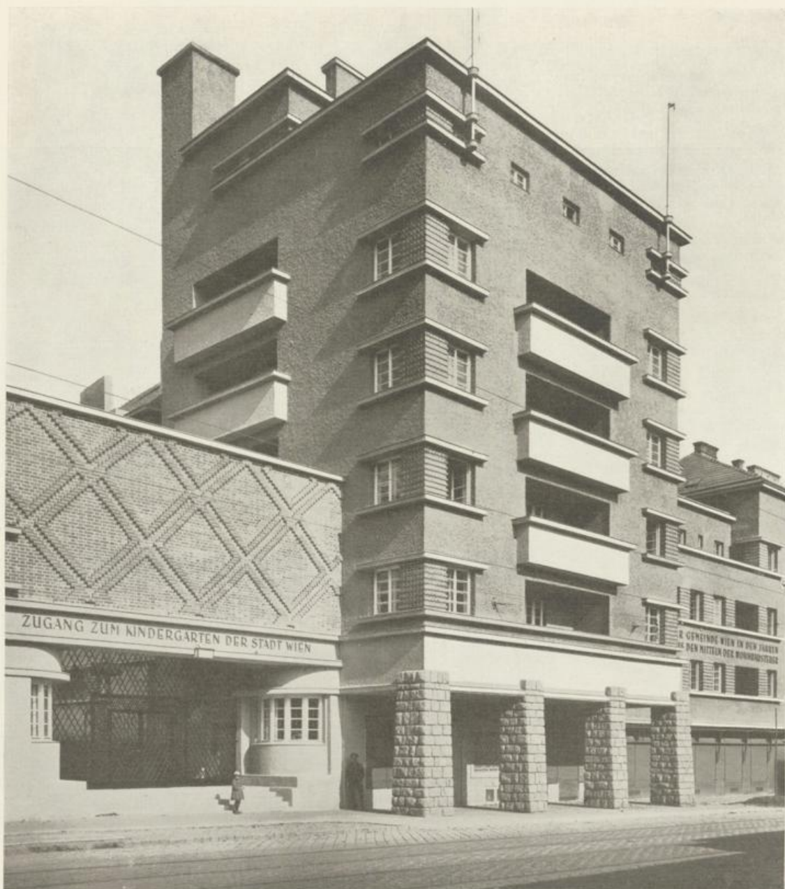
Teilansicht an der Hütteldorfer Straße
