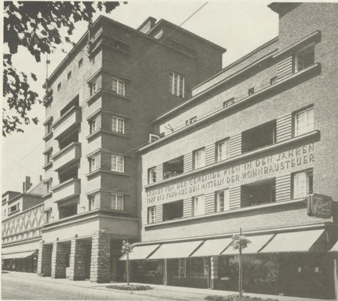
Teilansicht an der Hütteldorfer Straße
