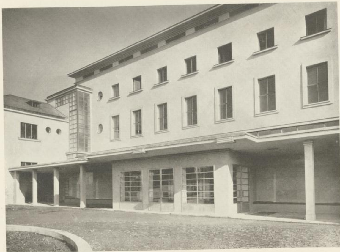
Ansicht gegen die Straße
