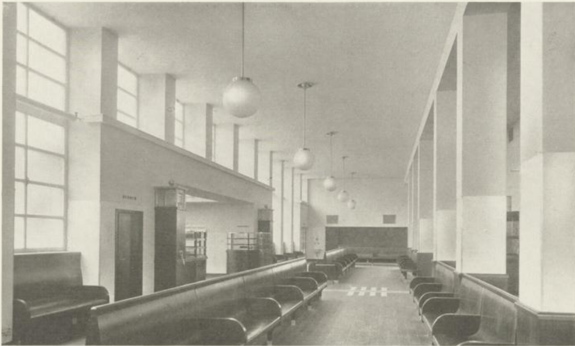
Wartesaal Wände in weißem Marmorglas. Türen aus Aluminium. Bodenbelag Fliesen
