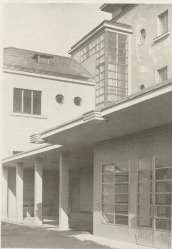
Eingangspartie mit gedeckten Hallen, Wände und Pfeiler derselben mit Unters- berger Marmor, Türen mit Aluminium ver- kleidet
