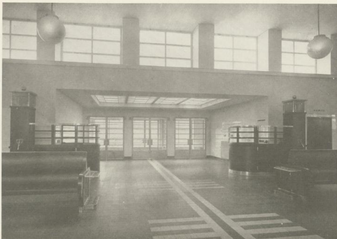
Wartesaal. Blick gegen Eingangshalle
