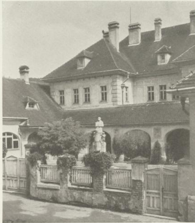
JOSEF HOFBAUER Schule und Gemeindehaus in Mauerbach, Niederösterreich
