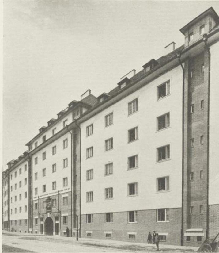
Fassade, X., Kennergasse
