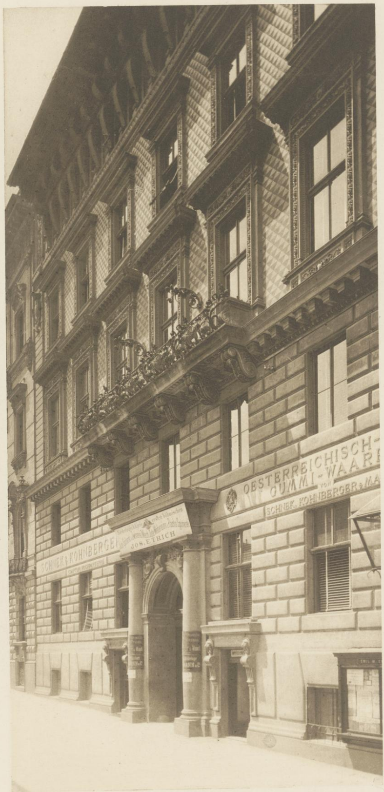
Althaus I. Schottenring 25 Fassade.
