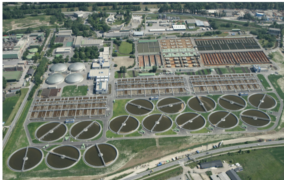
Abbildung 39: Hauptkläranlage Wien. © Foto: Stadt Wien
