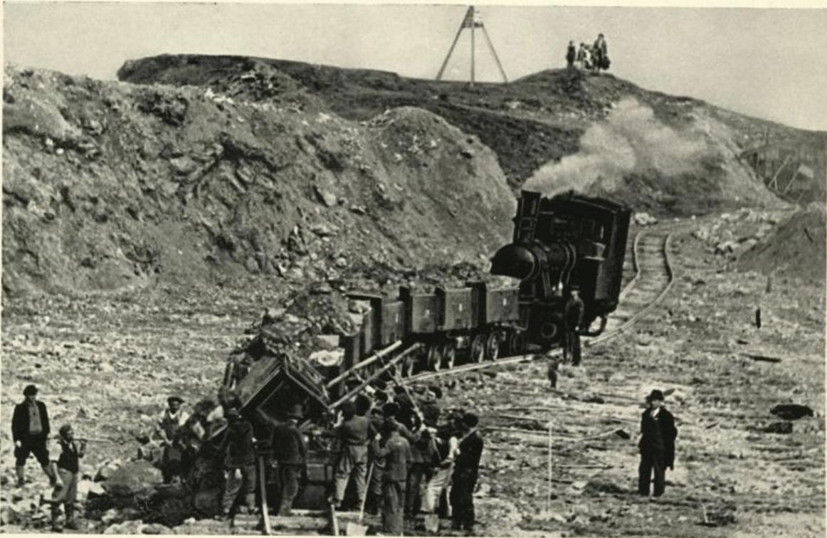
Bei Wien-Gießhübl wurde beim Bau der Reichsautobahn für die Anlegung der Trasse ein Steinbruch vollständig zugeschüttet
