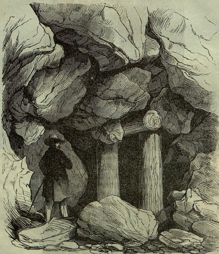
Verfallener Schacht auf dem Göstritz.
