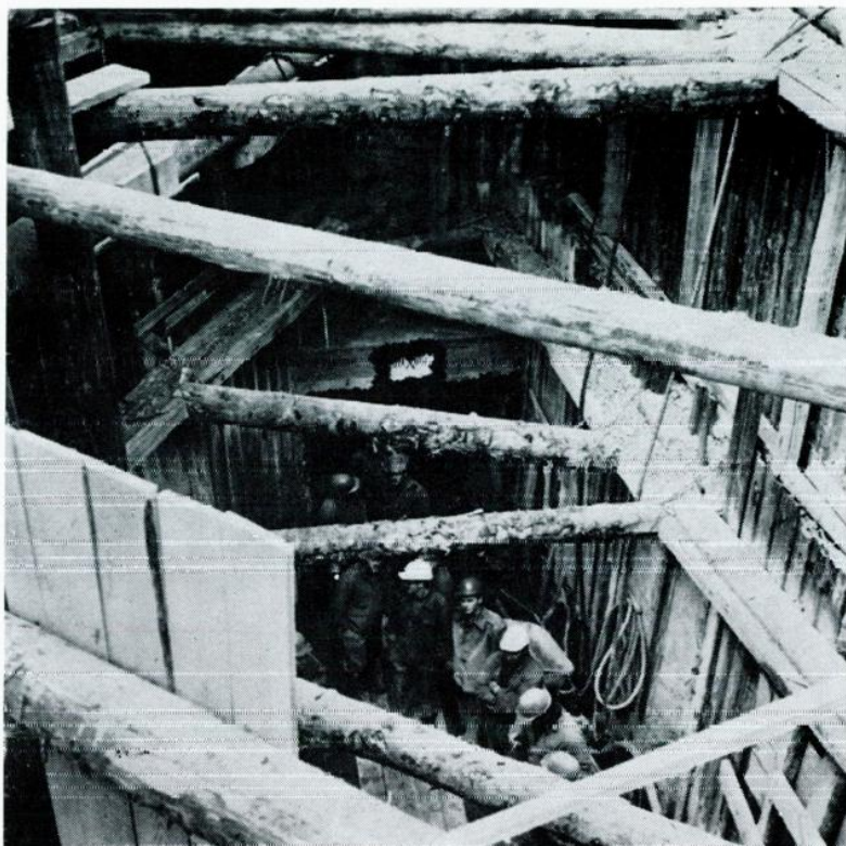
Der Bau des 600 m langen, unter der Hernalser Hauptstraße führenden Alsbach-Entlastungskanal erfolgt im Minierungsverfahren durch Stollenvortrieb
