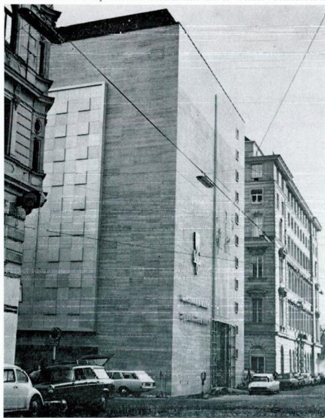
Das neue 110/10 kV-Umspannwerk Zedlitzhalle im 1. Wiener Gemeindebezirk
