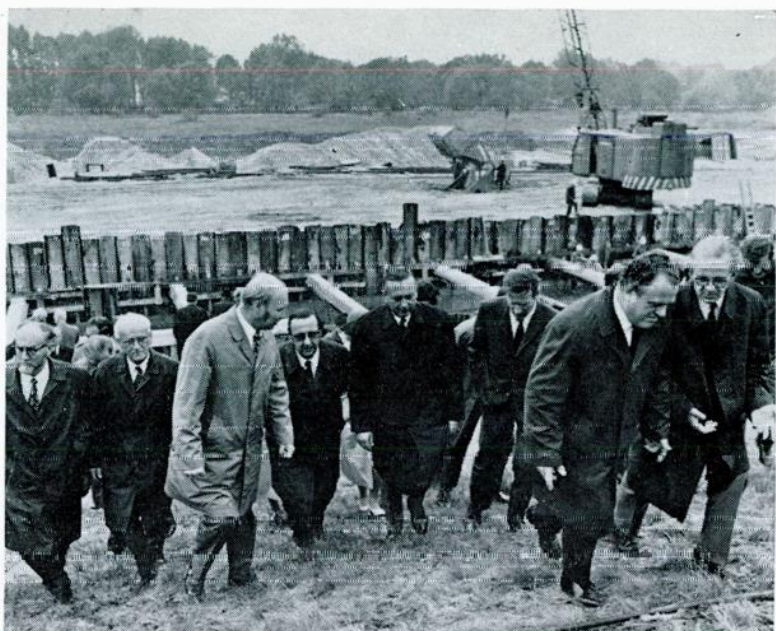
Bautenminister Josef Moser, Bürgermeister Felix Slavik und Stadtrat Kurt Heller (Tiefbau) besichtigen die Baustellen des großen Donau-Hochwasserschutzprojekts in Wien
