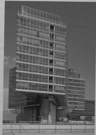
Das Strabag-Haus. Foto.
