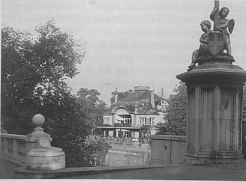
Die Meierei vor der Renovierung. Foto.
