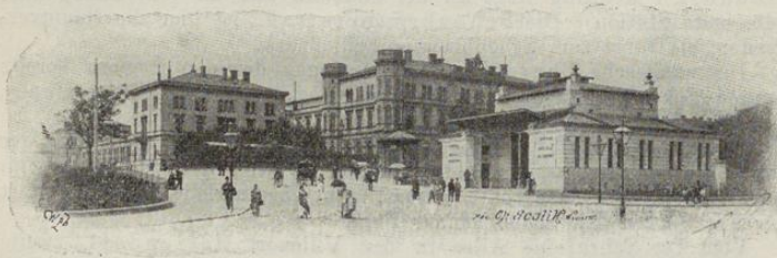
Westbahnhof. (Mit der Stadtbahnstation).
