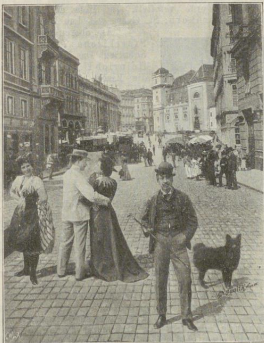
Freiung mit Schottenkirche.
