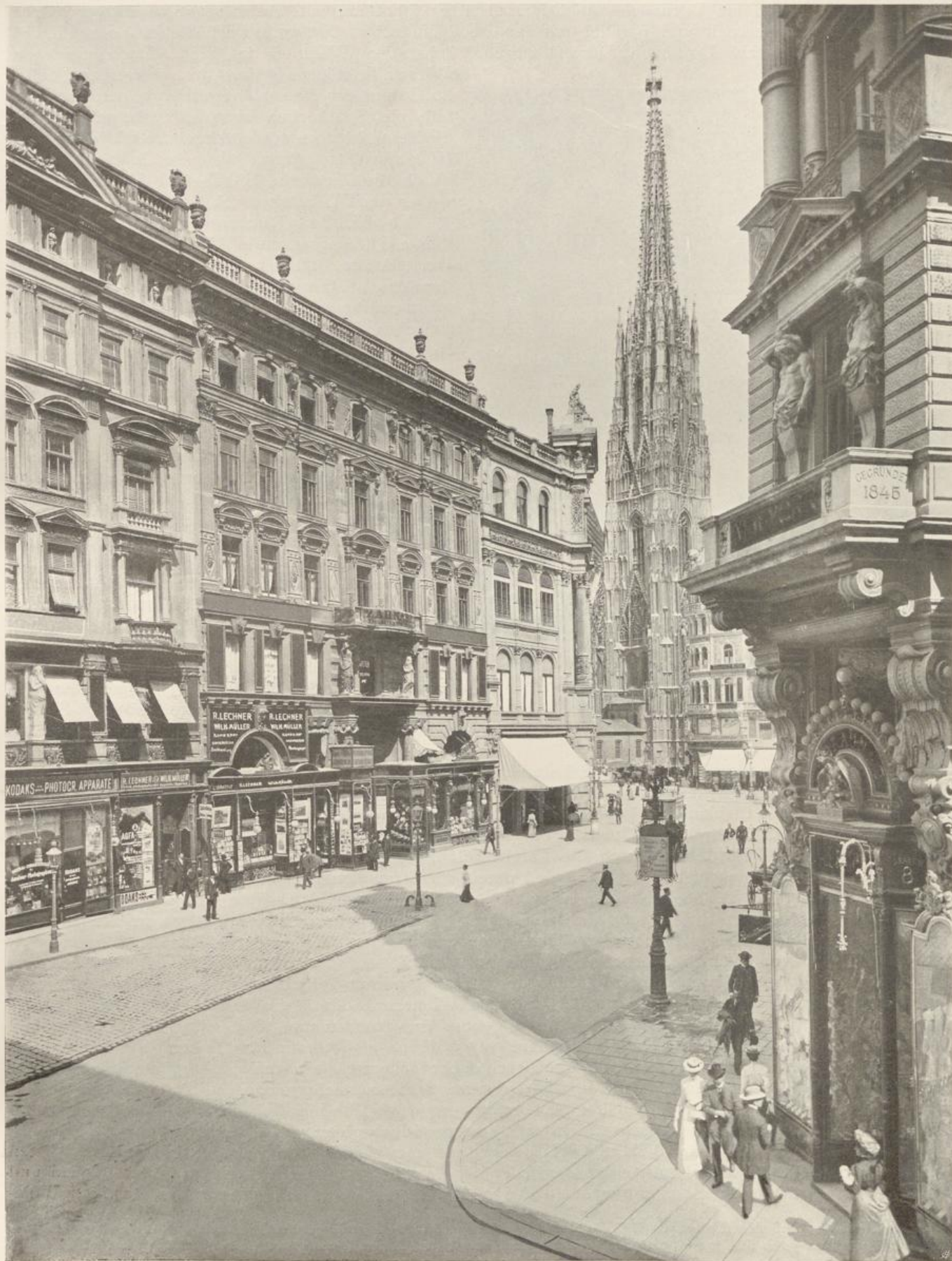
BLICK VOM GRABEN GEGEN DEN STEPHANSTURM.
