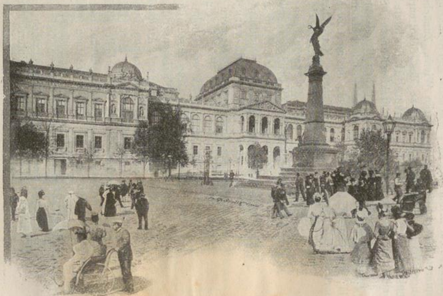
Universitätsgebäude mit Liebenberg-Denkmal.
