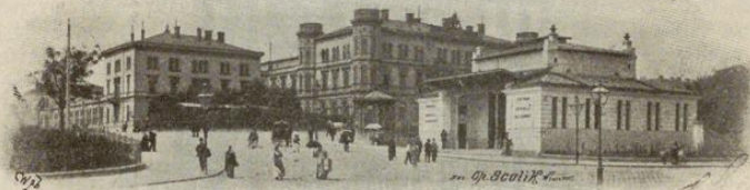
Westbahnhof (Mit der Stadtbahnstation).
