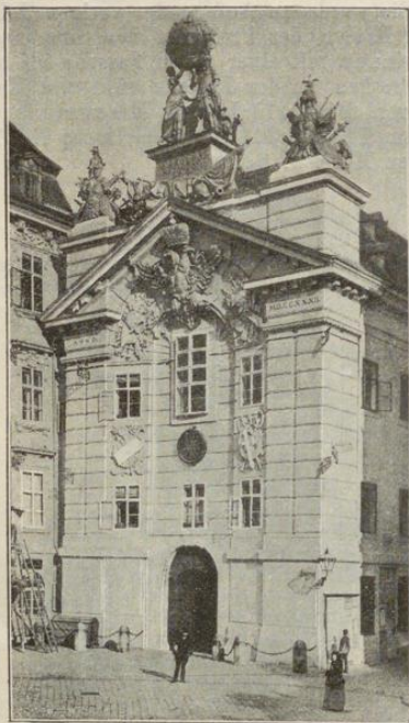
Gebäude der Feuerwehrezentrale. (Ehemaliges Zeughaus am Hof.)
