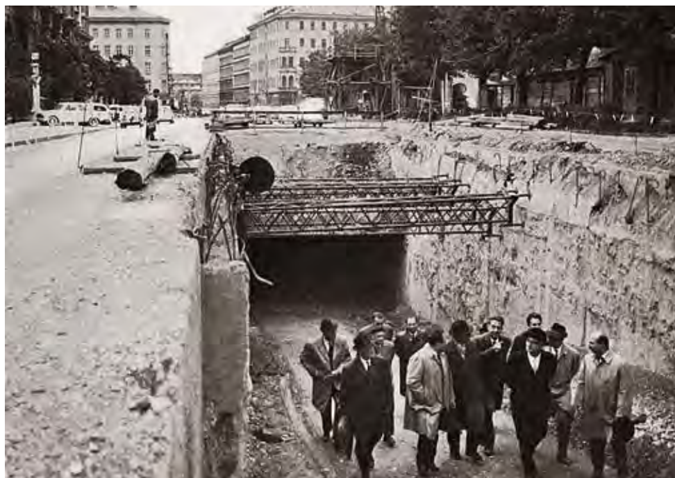
Bundespräsident Franz Jonas besucht die USTRAB-Bauarbeiten auf der Zweierlinie
