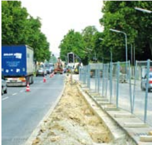
▲ Eine Lärmschutzwand entsteht ... (Juli 2009)
