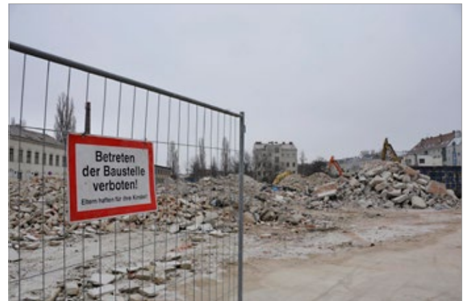
Baustellen bedeuten Feinstaubbelastung.
