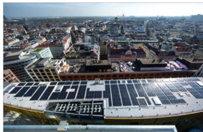
Das „BürgerInnen-Solkraftwerk“ am Bahnhof Wien Mitte.
