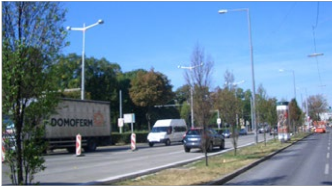
Bessere Ausleuchtung und weniger Verbrauch bei der Beleuchtung am Gürtel.
