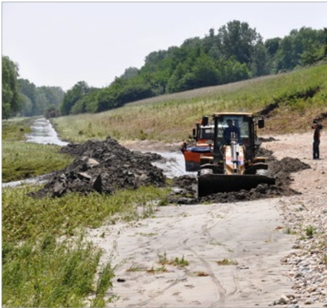
Aufräumarbeiten nach dem Jahrhundert-Hochwasser.
