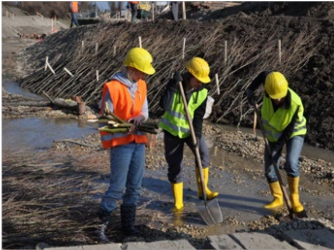
Studenten der BOKU helfen bei der Renaturierung des Liesingbachs.
