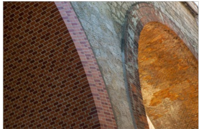
Aquädukt-Detail mit sanierter und unsanierter Bogenuntersicht.
