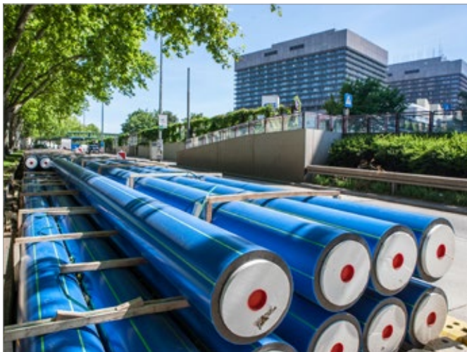
Rohre warten auf ihren Einbau am Währinger Gürtel.
