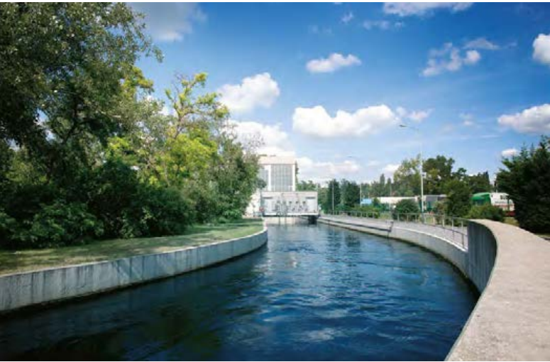
Das gereinigte Wasser fließt in die Donau © ebswien
