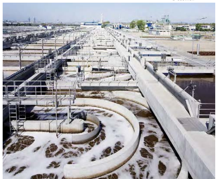
Im Belebungsbecken arbeiten Bakterien © ebiswien
