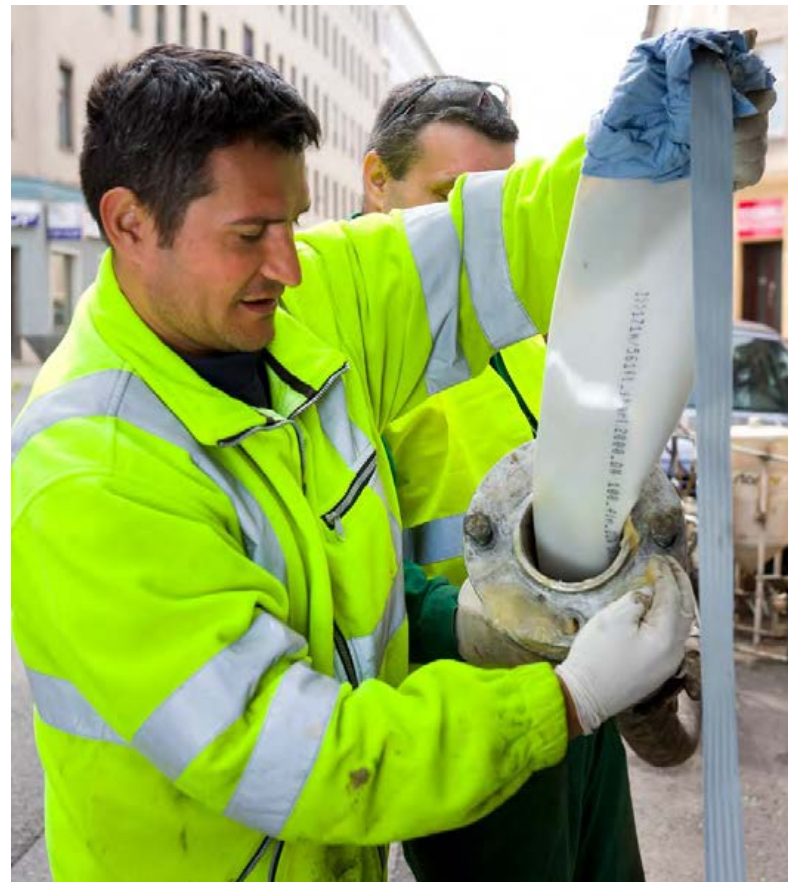
Relining spart Grabungsarbeiten © Martin Stickler (Wiener Netze)
