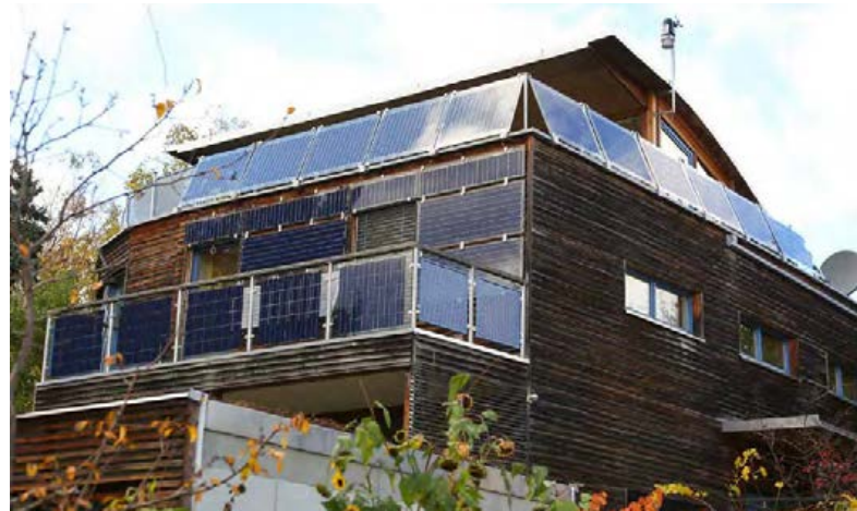
Solaranlagen sind nun in der Bauordnung verankert © Ertex Solartechnik
