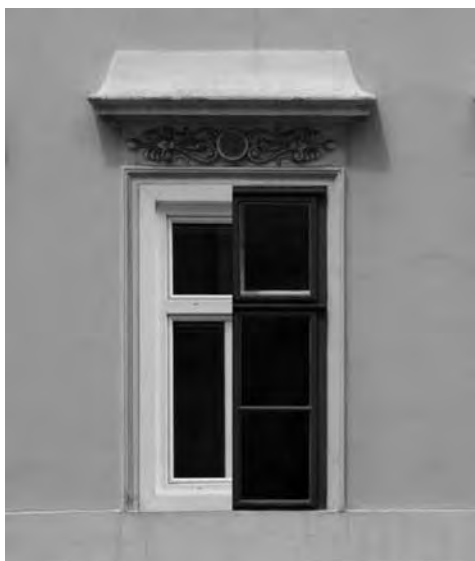
Vergleich eines Kastenfensters mit schmalen Rahmen und eines Isolierglasfensters mit verkleinerter Fensteröffnung durch eine Mauerisolierung © MA 19, Martin Kupf
