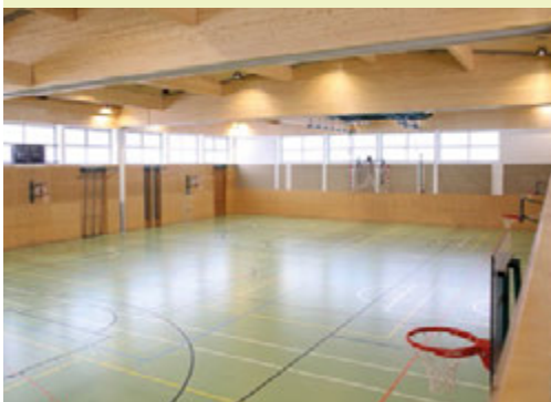
Pastorstraße (neues Dach mit LED-Beleuchtung)
