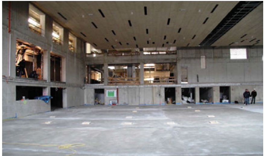
Sonwendviertel: Bauphase der Dreifachturnhalle
