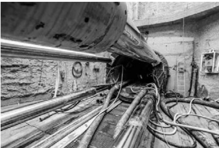
Mittels hydraulischer Pressen werden 18 Tonnen schwere Kanalrohre aus Stahlbeton in den Untergrund geschoben. © Fürthner
