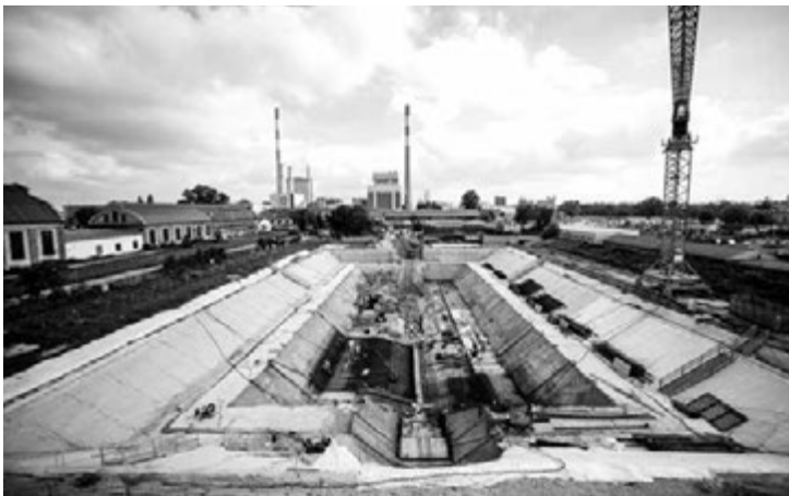
Bau des gigantischen Beckens am ehemaligen Fußballplatz. © Ian Ehm
