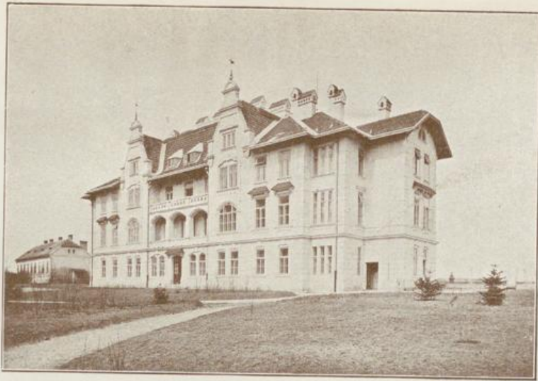
Südseite Pavillon I—IV.
