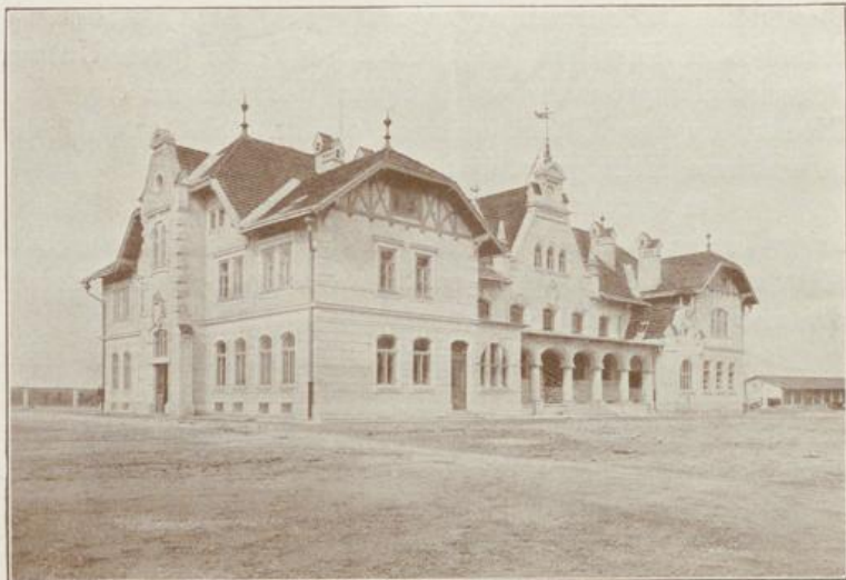
Fassade Objekt VI.
