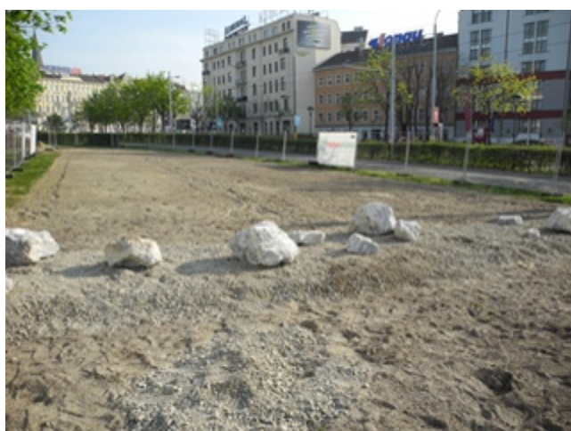
Abb. 3: Knapp vor Ende der Erdarbeiten – Kalksteine werden noch eingebaut
