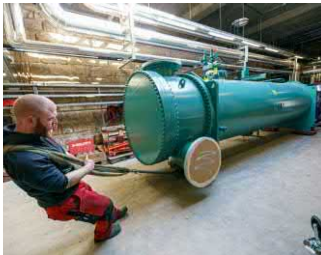
Anlieferung der neuen Turbokältemaschine für die Fernkältezentrale Spittelau
