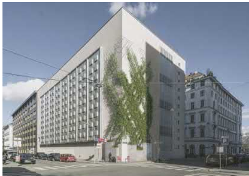
Das Umspannwerk Stubenbastei wird begrünt
