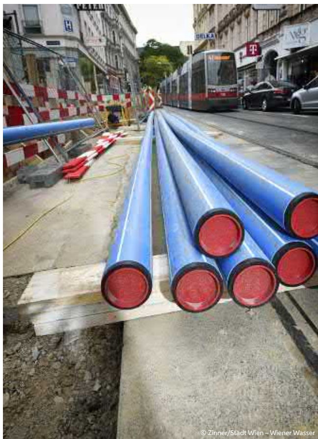
Die Währinger Straße während der Bauarbeiten
