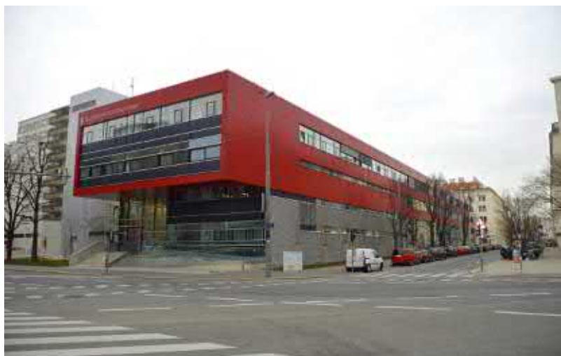
Die neue Hauptfeuerwache Leopoldstadt
