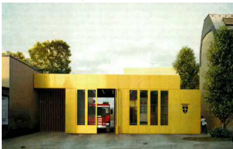
Auch weitere Stützpunkte der Feuerwehr werden auf Niedrigenergiestandard umgestellt
